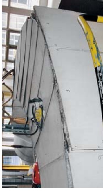
Isolamento posto dietro un rivestimento
