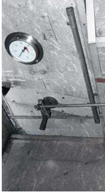
Canale di ventilazione in pannelli di fibrociamento
